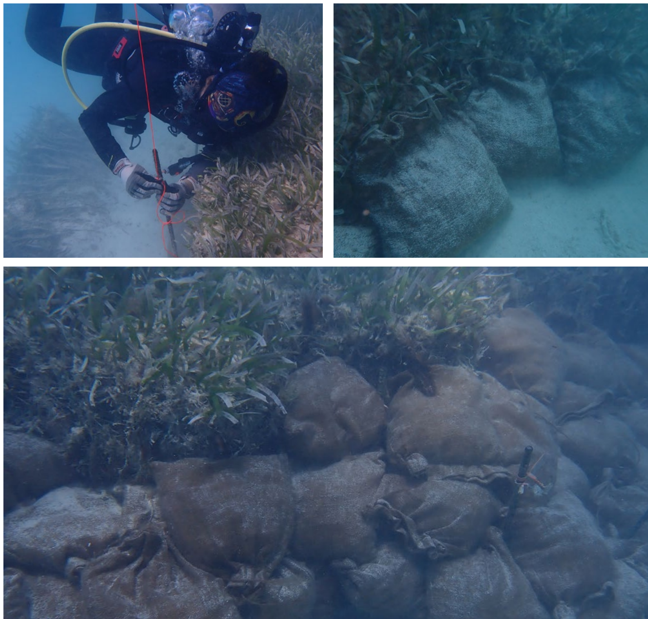
Figura 6. Instalación de Solución basada en la naturaleza ( SbN) en diciembre de 2025.
