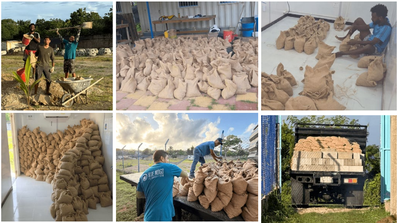
Figura 5. Preparación de las SbN, sacos de yute rellenos de piedra calcárea.
