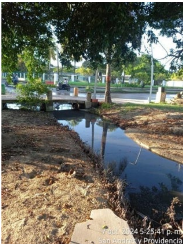
Ilustración 2. Desagüe pluvial en el sector norte de San Andrés, receptor y emisor de vertimientos ocasionales de Aguas Residuales al mar
