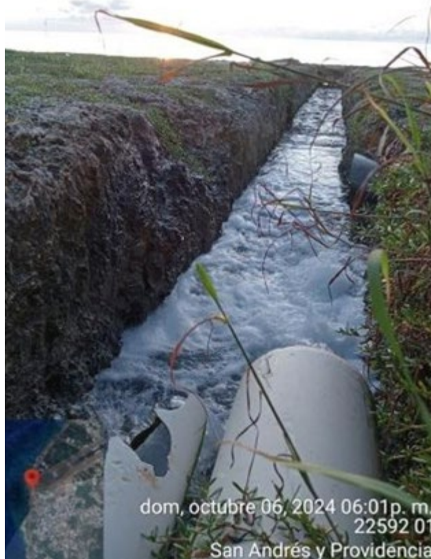
Ilustración 3. Vertimiento de salmueras al mar subproducto de la desalinización de agua de mar para potabilización, en el sector occidental de San Andrés
